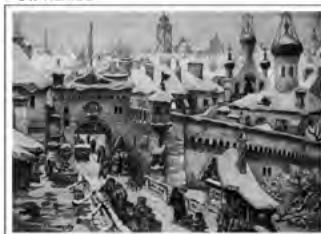
Išganytojo (Spaso) vartų rekonstrukcija
